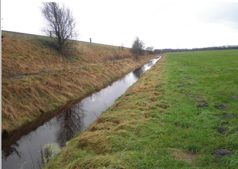
Foto 3: Graben südöstlich entlang der Bahn
