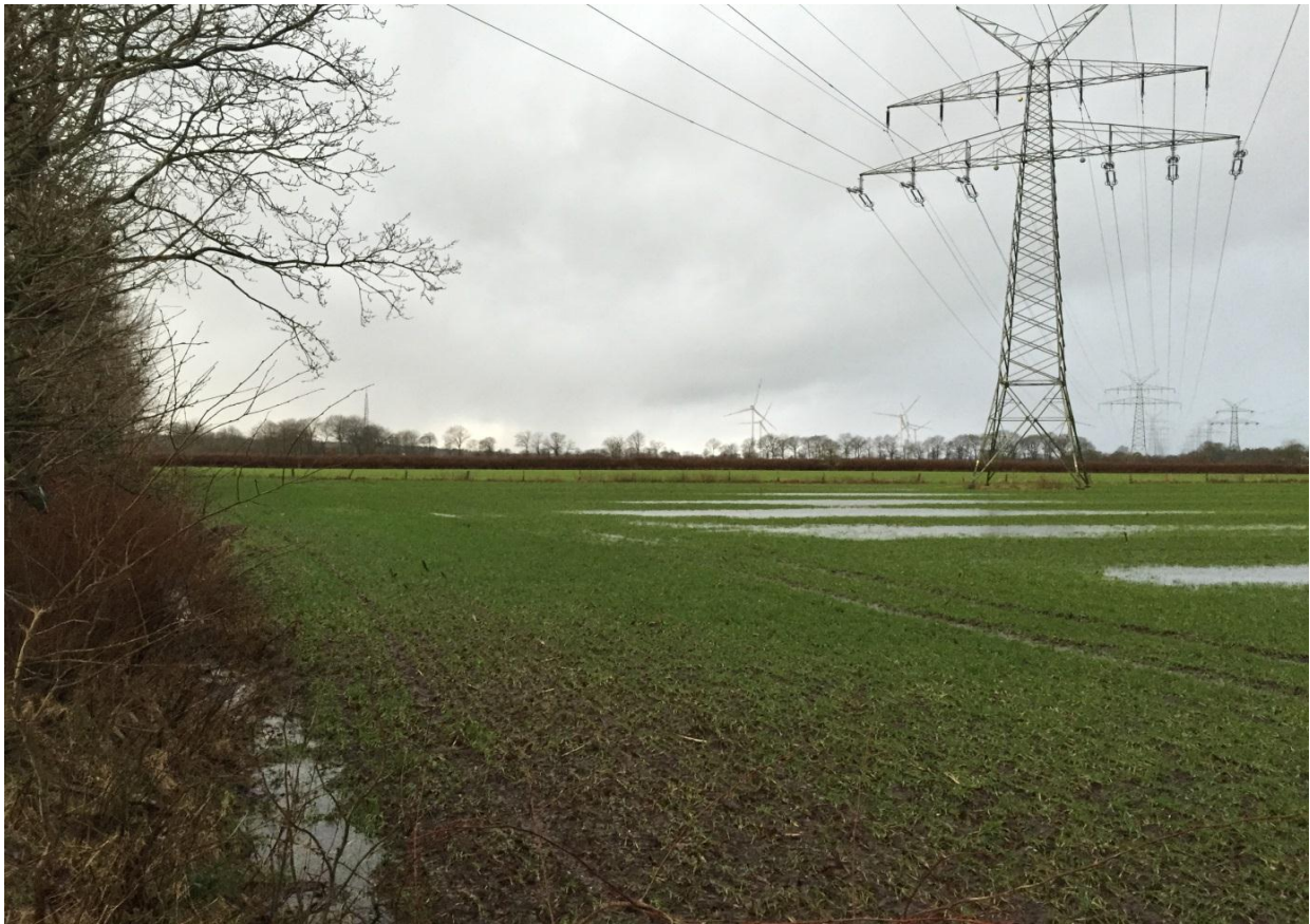
Bild 1: Maststandort; Blickrichtung: Nordwest
