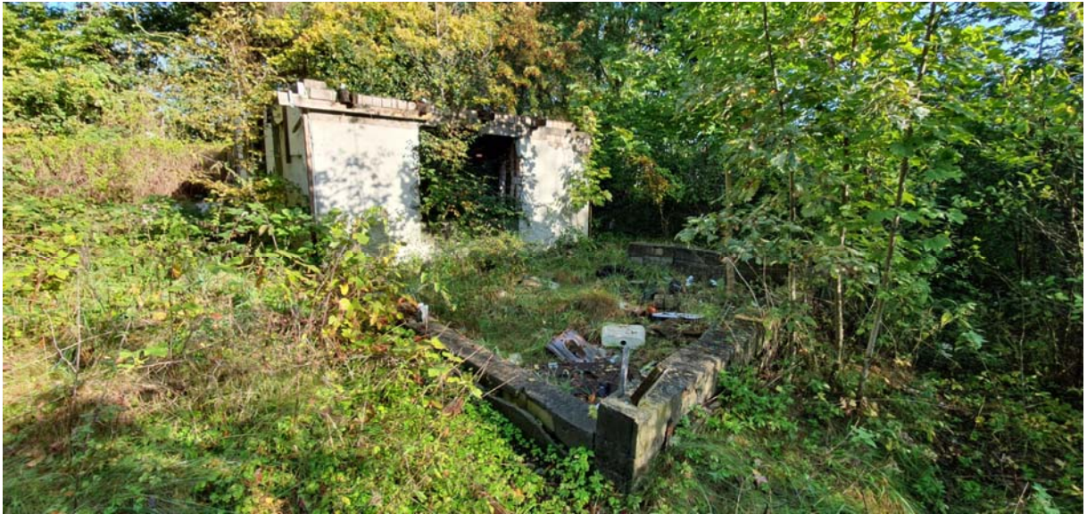
Bild 3 exemplarische Reste aus ehemaliger Kleingartensiedlung
