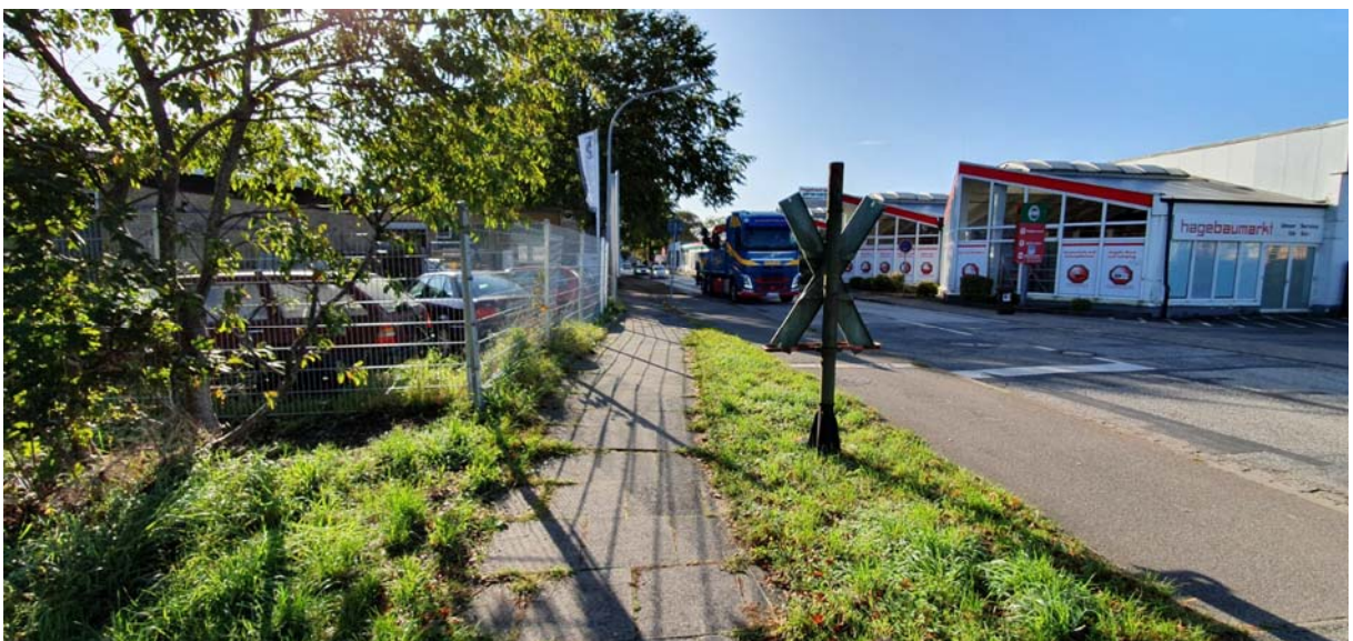
Bild 6 BÜ Friedrichstädter Straße, Blickrichtung Süden
