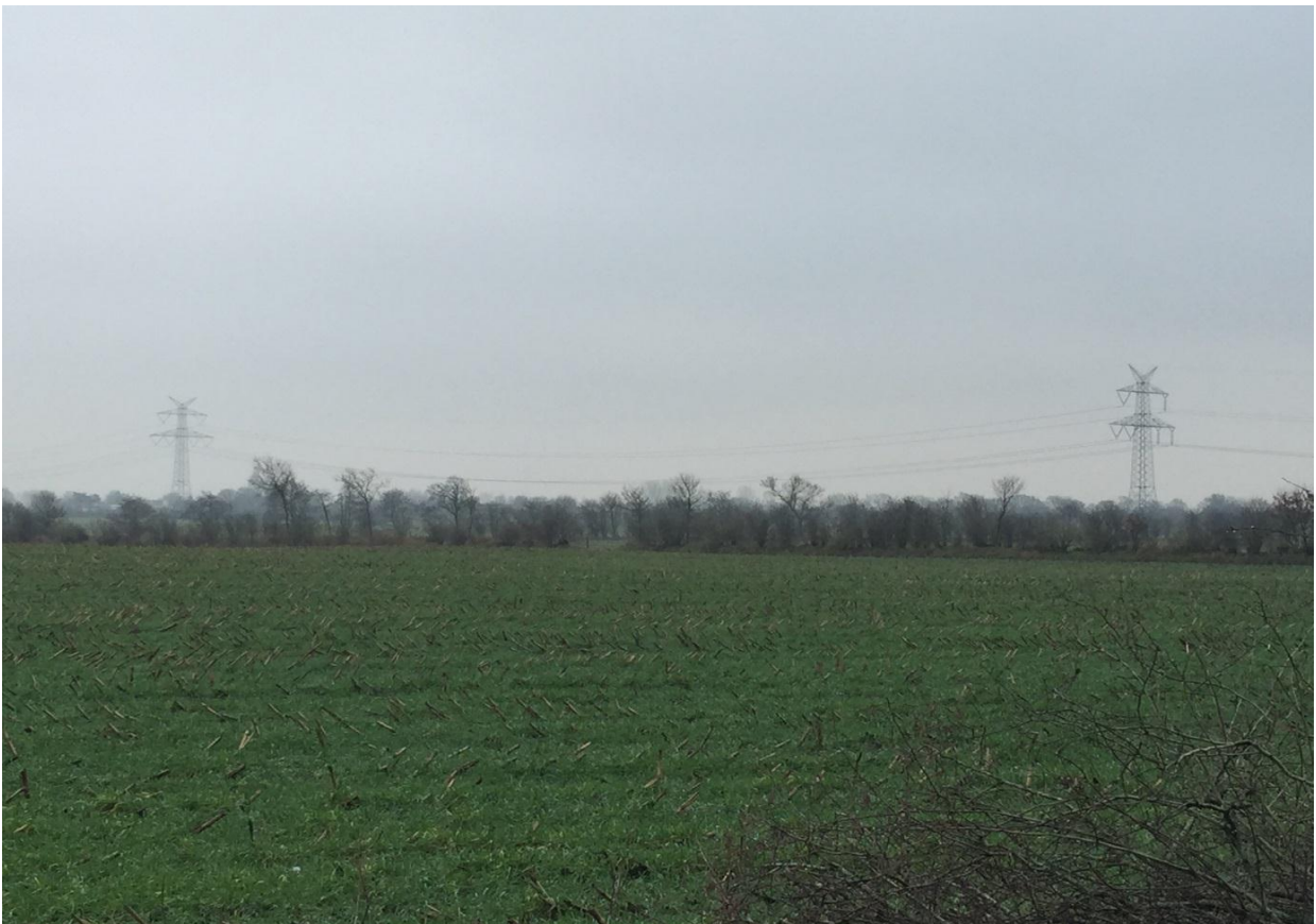
Bild 2: Maststandort; Blickrichtung: West
