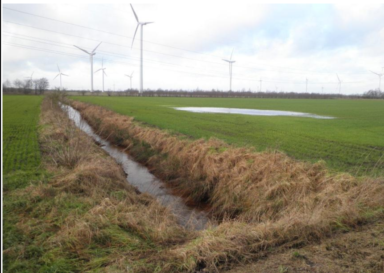
Foto 2: Graben (Flurstück 2) ca. 10 m nördlich
