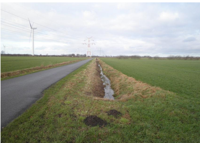
Foto 3: Straßenrandgraben ca. 150 m westlich
