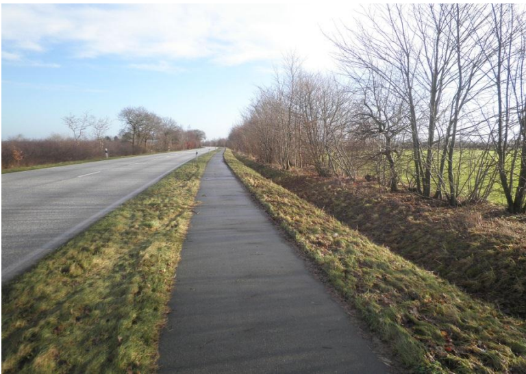
Foto 2: Straßenrandgraben (B 201, Flurstück 9/5) ca. 240 m nördlich
