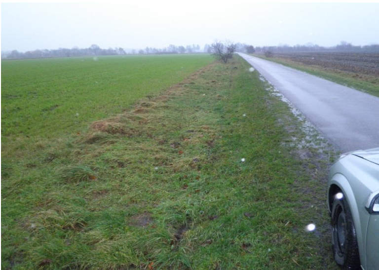
Foto 3: Straßenrandgraben ca. 110 m westlich
