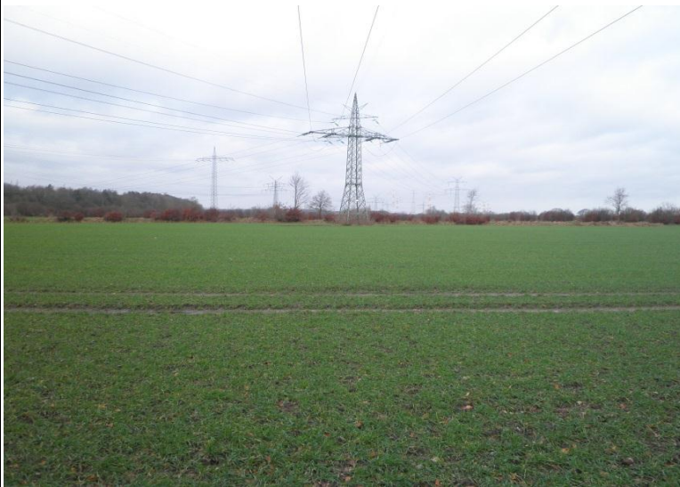
Foto 1: geplanter Standort/vorhandener Mast
