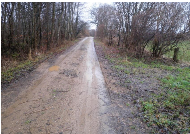
Foto 3: Graben und Weg nordwestlich
