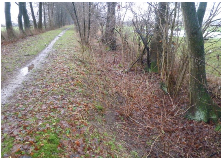
Foto 2: Graben und Dammbereich östlich
