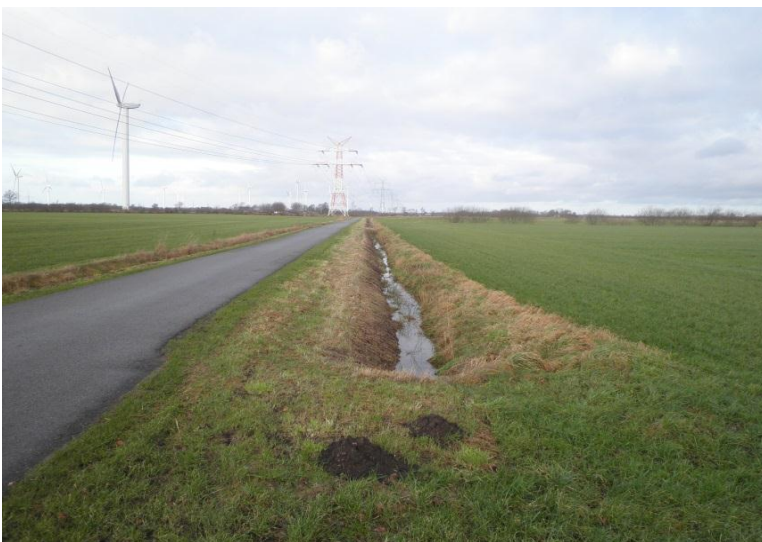
Foto 3: Straßenrandgraben ca. 100 m westlich
