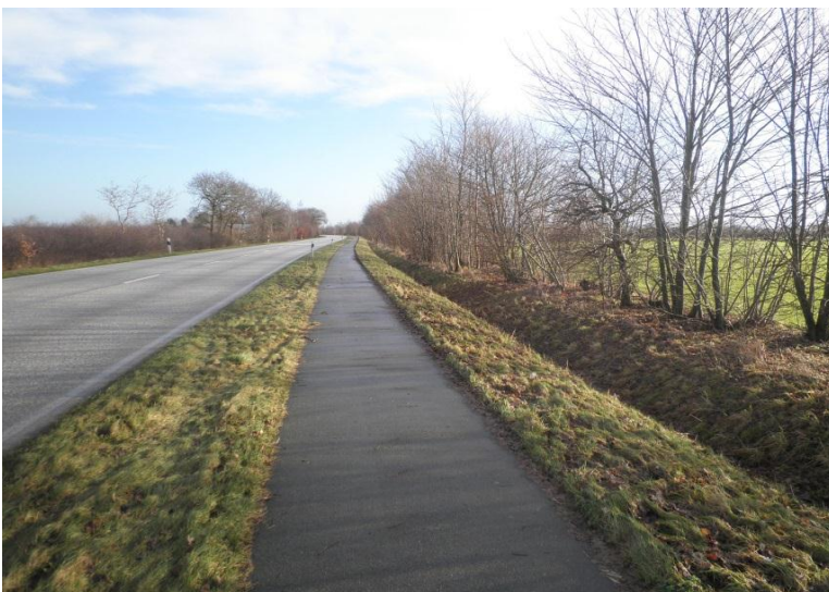
Foto 2: Straßenrandgraben (B 201, Flurstück 9/5) ca. 220 m nördlich
