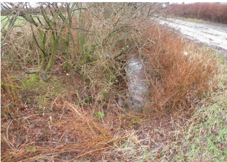
Foto 3: Straßenrandgraben ca. 450 m nordwestlich
