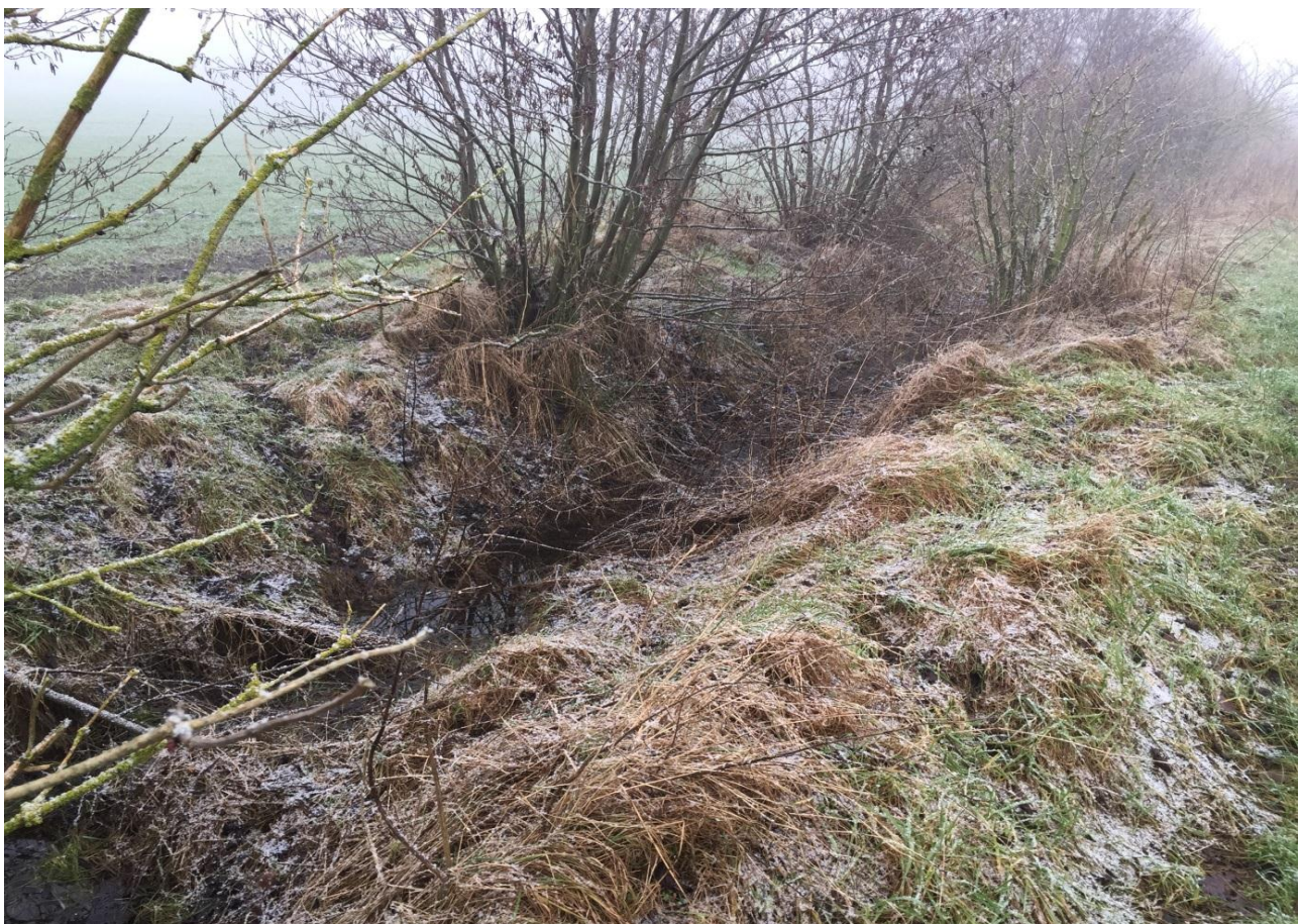
Bild 2: Grenzgraben, stark verkrautet
