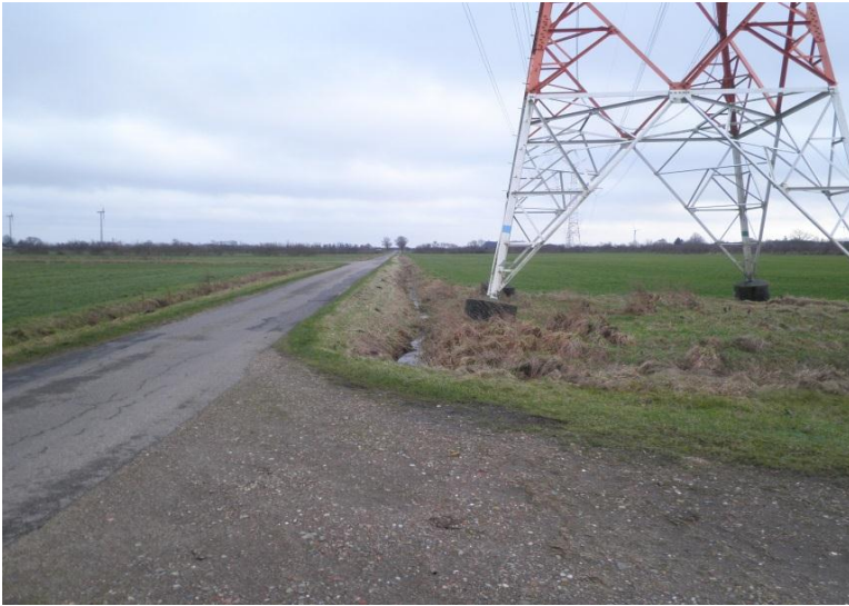
Foto 1: Standort - vorhandener Mast mit Straßenrandgraben
