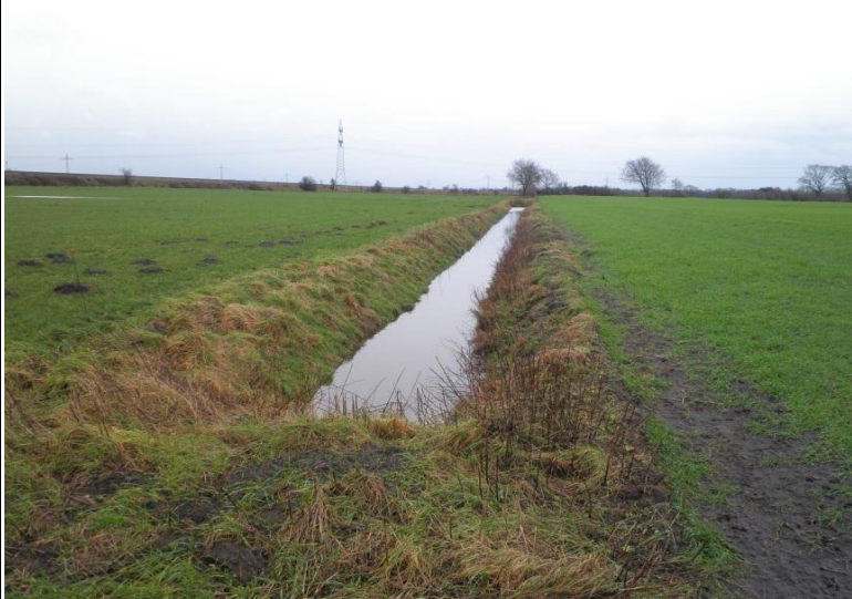
Foto 2: Graben direkt westlich
