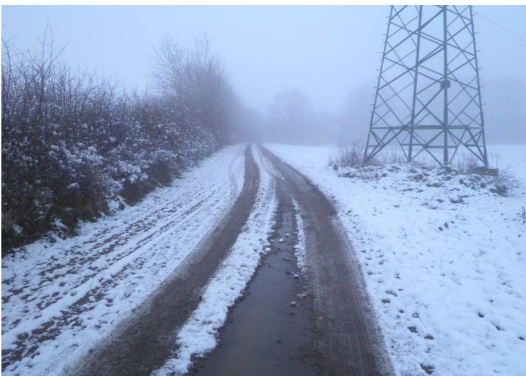
Foto 3: Weg und vorhandener Mast nordöstlich Standort
