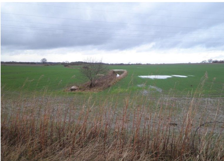
Foto 2: Graben ca. 350 m südöstlich
