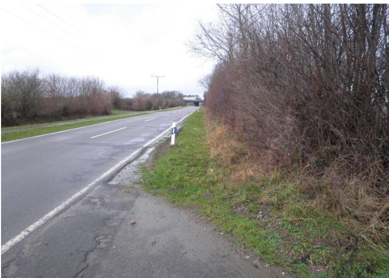
Foto 3: Straßenrandgraben an K 30
