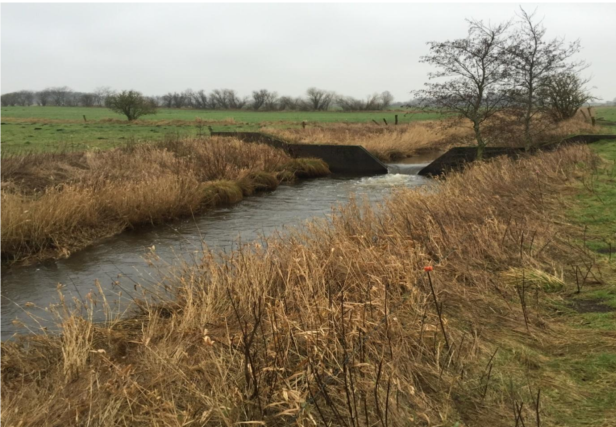
Bild 2: Einleitstelle; Verbandsgraben; Blickrichtung: West
