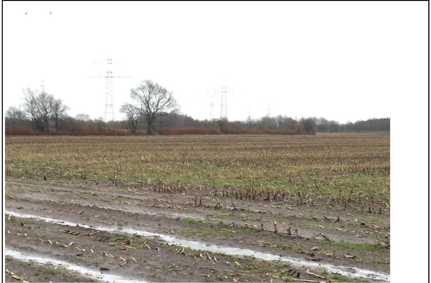
Bild 1: Maststandort; Blickrichtung: Südost
