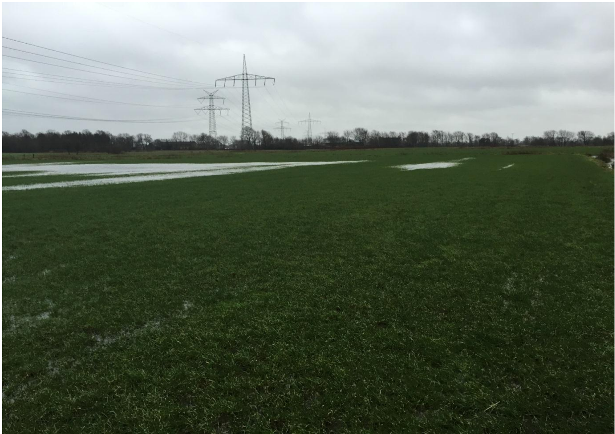
Bild 1: Maststandort; Blickrichtung: Nord
