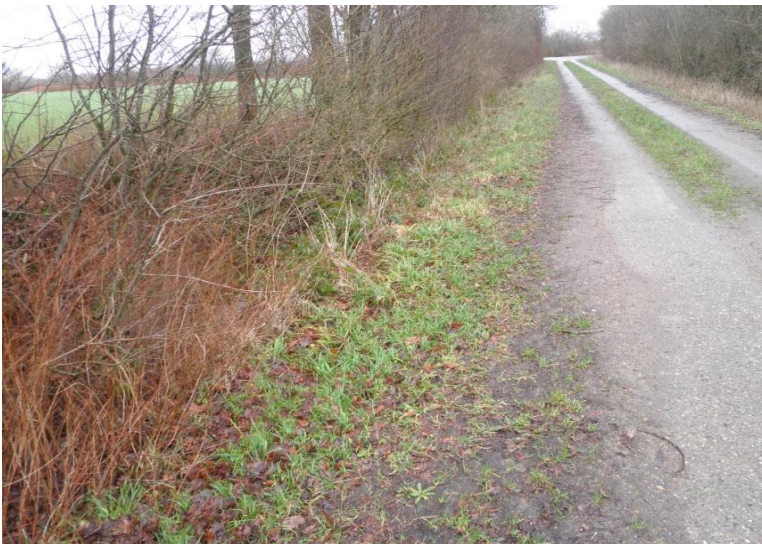
Bild 2: Straßenrandgraben ca. 150 m südlich
