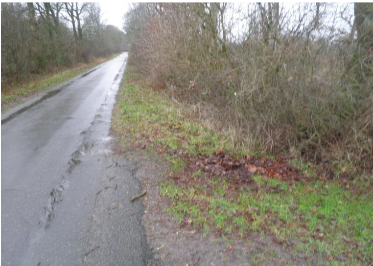
Bild 2: Straßenrandgraben ca. 190 m nordwestlich
