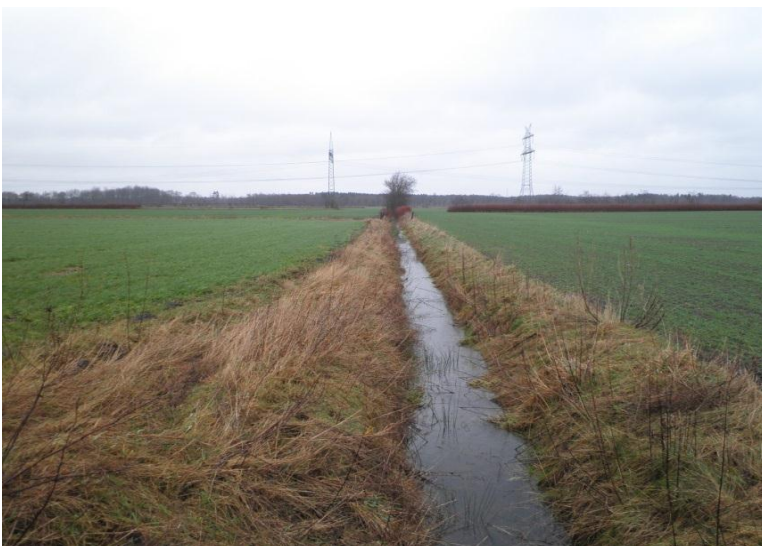
Bild 2: Graben (Flurstück 40) ca. 300 m südöstlich
