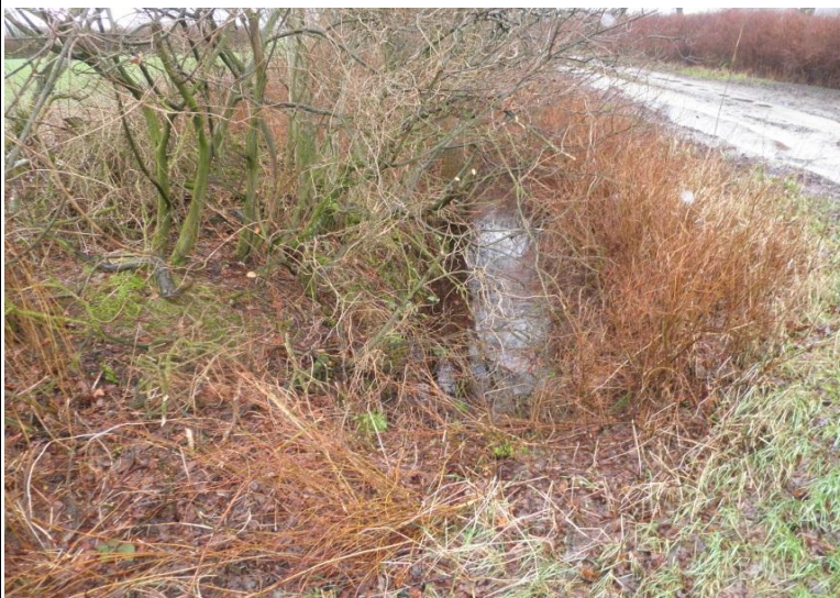
Bild 3: Straßenrandgraben ca. 380 m nordwestlich
