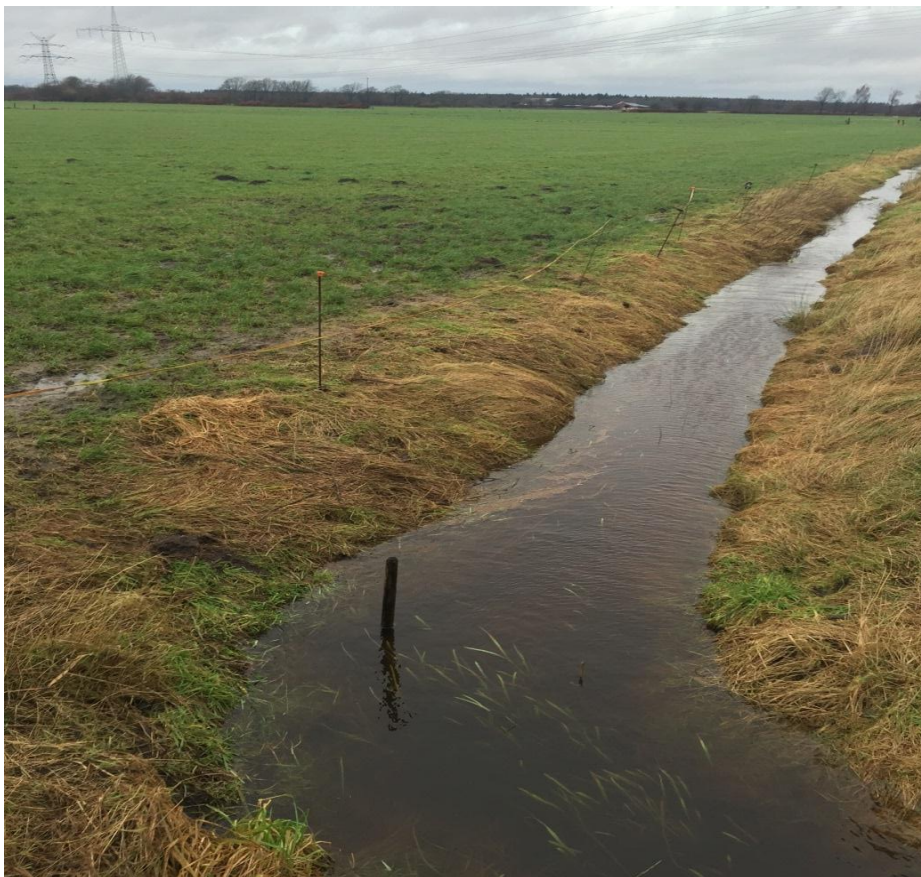
Bild 2: Übergabepunkt, nur für Niederschlagswasser geeignet; Blickrichtung: Nordost
