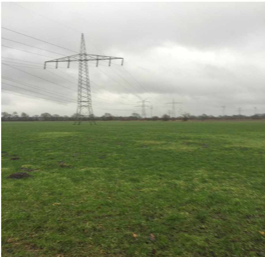
Bild 2: Maststandort; Übersicht; Blickrichtung: Südost
