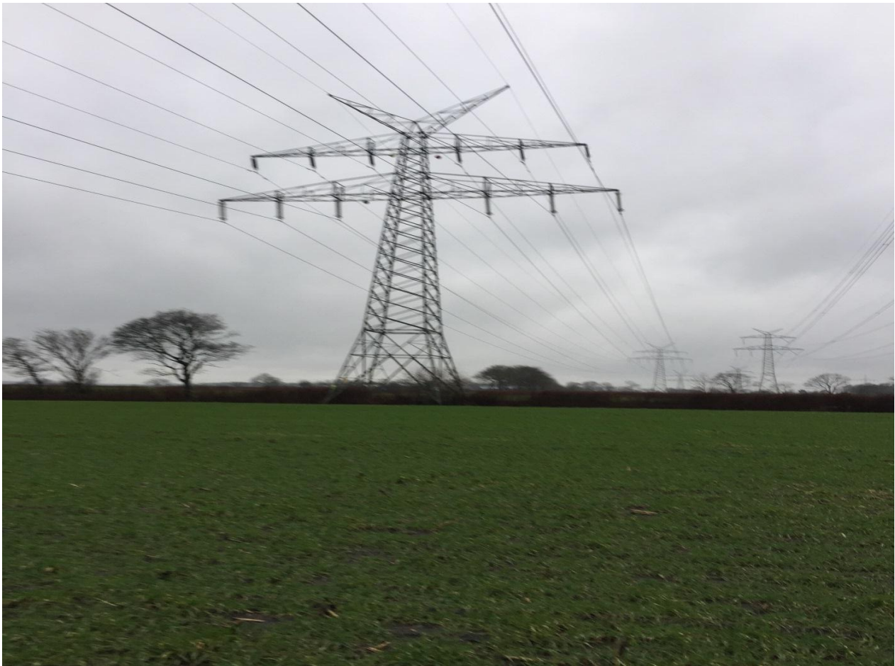
Bild 1: Maststandort; Blickrichtung: Nordwest
