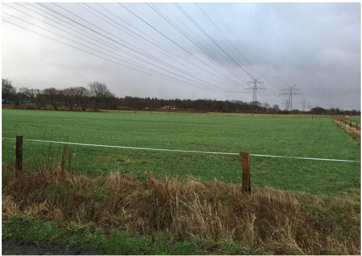
Bild 1: Maststandort, Blickrichtung: Ost
