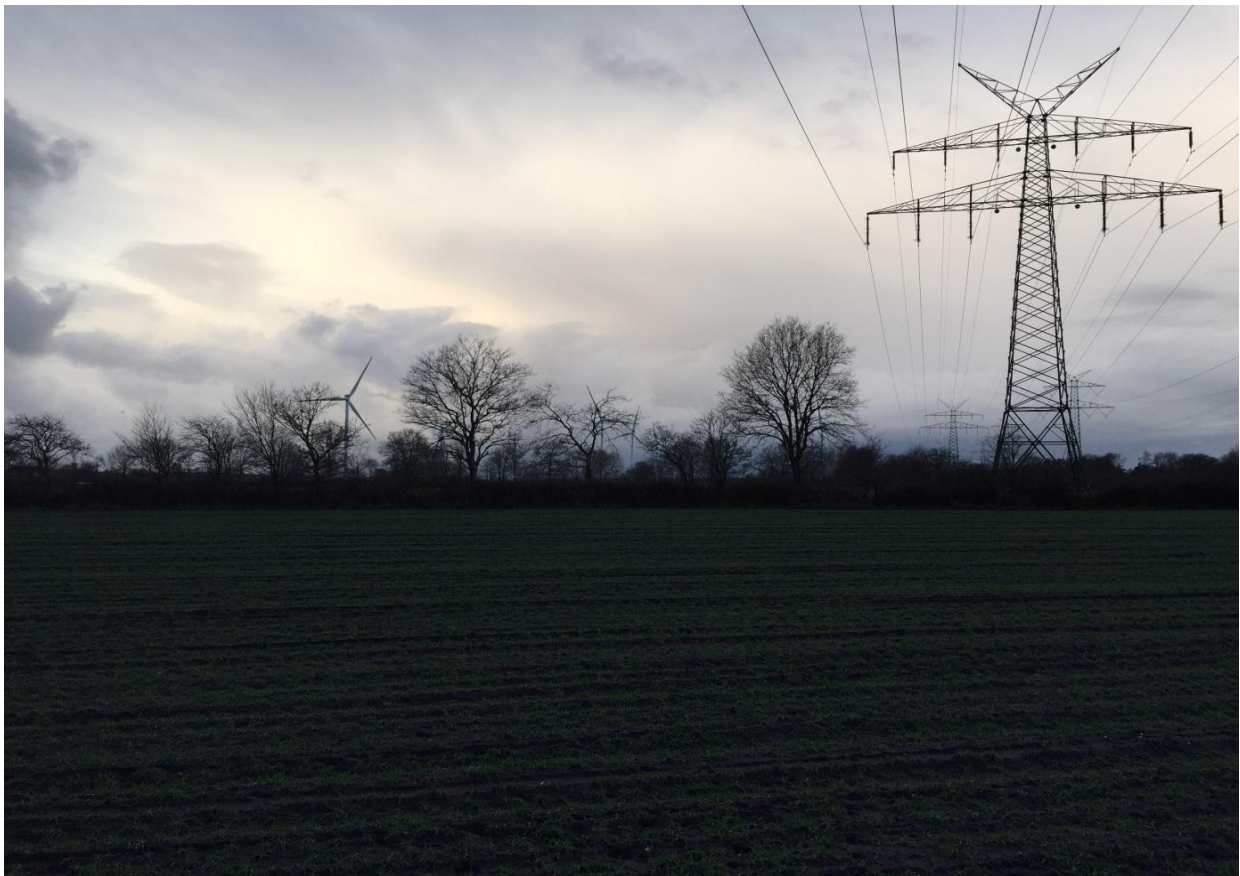
Bild 1: Maststandort; Blickrichtung: West
