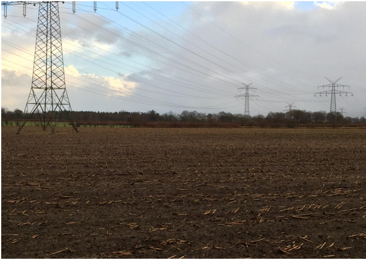
Bild 1: Maststandort; Blickrichtung: Nord
