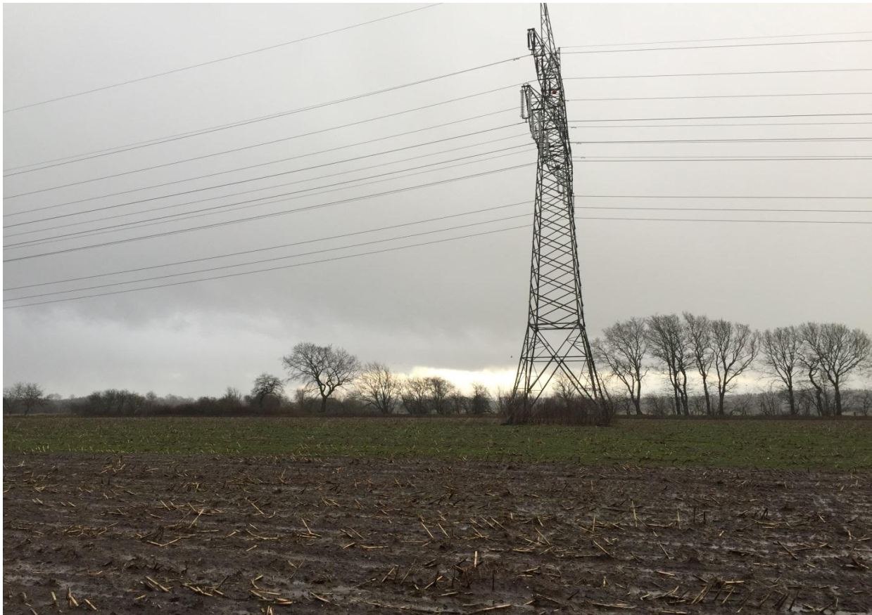
Bild 1: Maststandort; Blickrichtung: Nord
