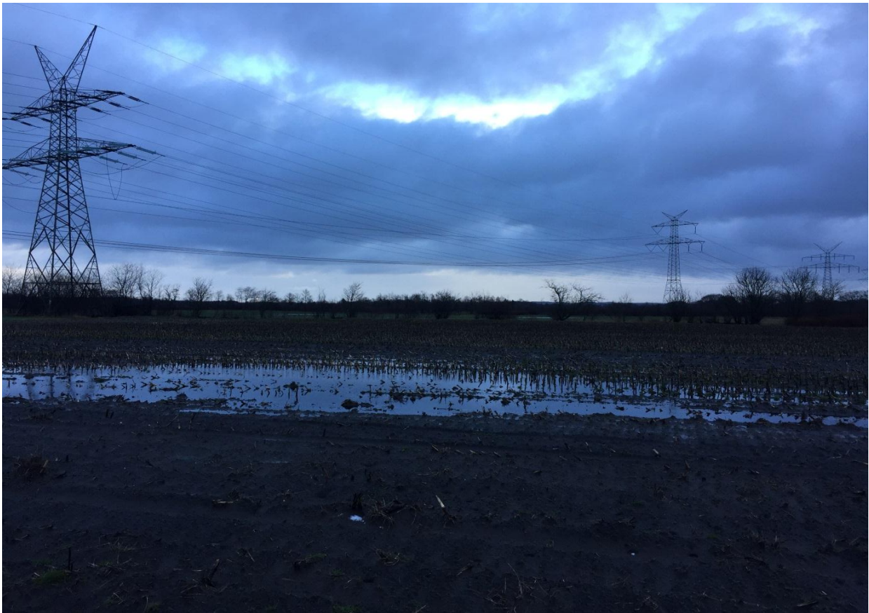
Bild 1: Maststandort; Blickrichtung: Nordwest
