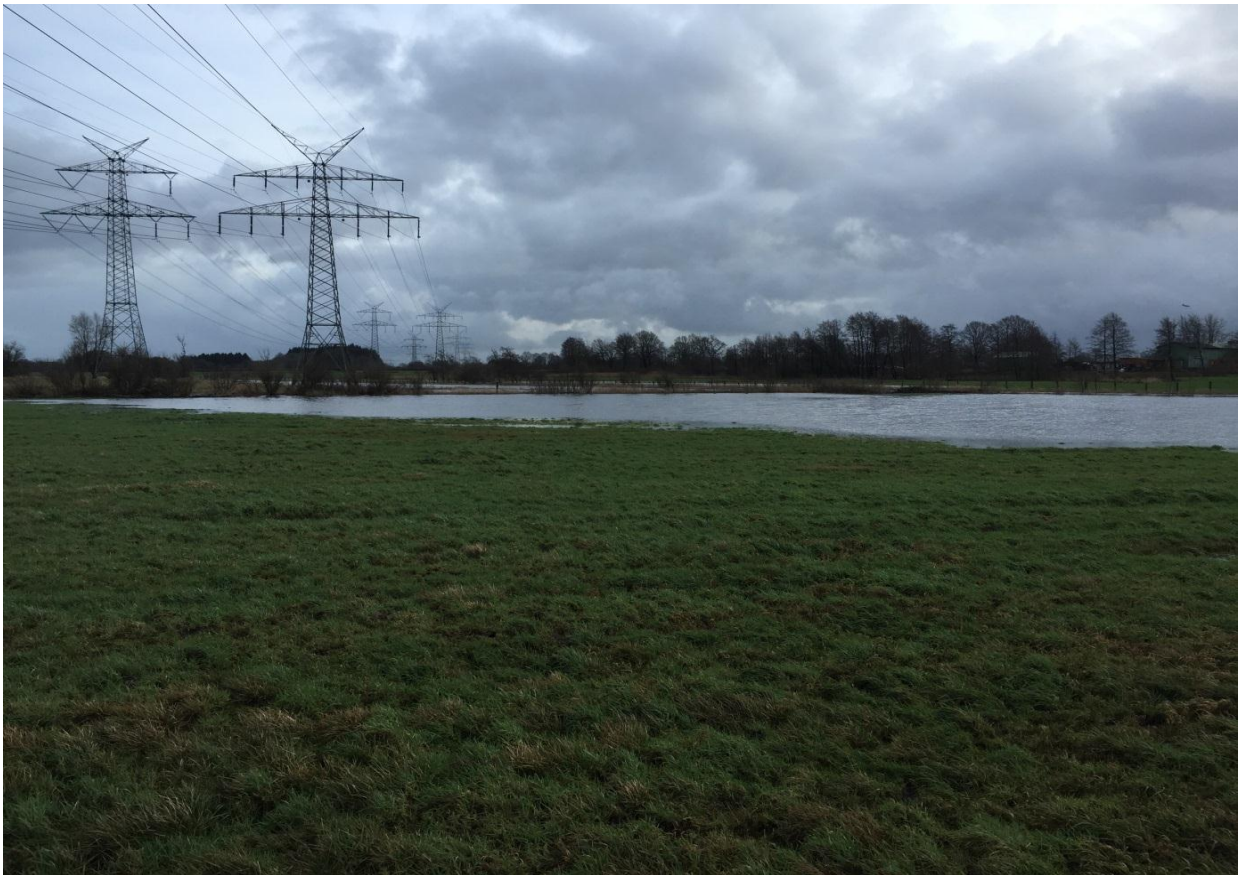
Bild 1: Maststandort; Blickrichtung. Südost
