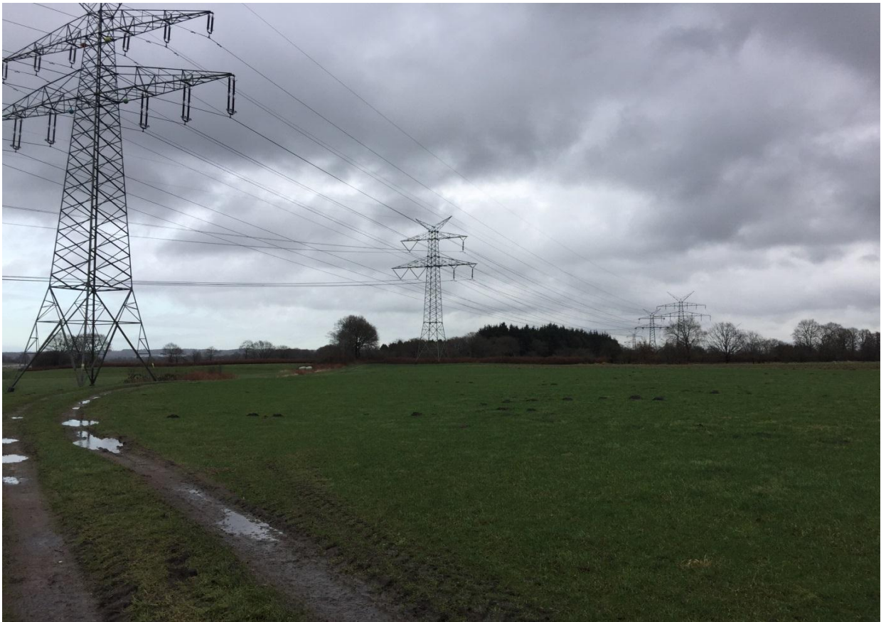
Bild 1: Maststandort; Blickrichtung: Süd
