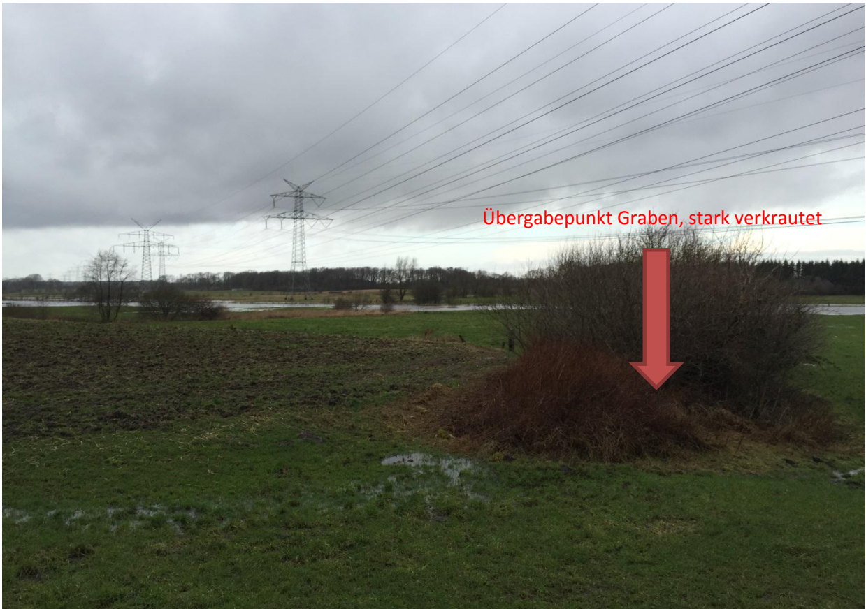
Bild 2: Übergabepunkt; nordöstlich Maststandort
