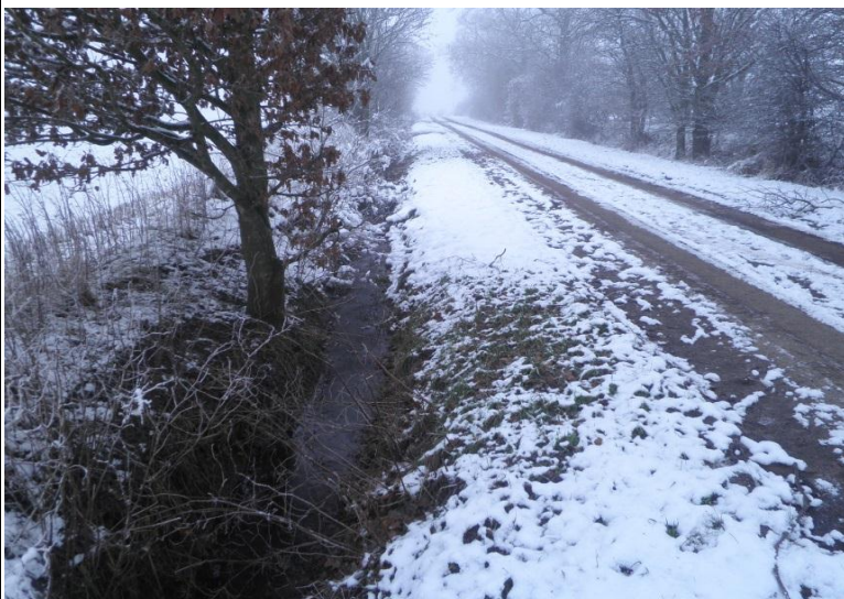
Foto 2: Straßenrandgraben ca. 20 m östlich
