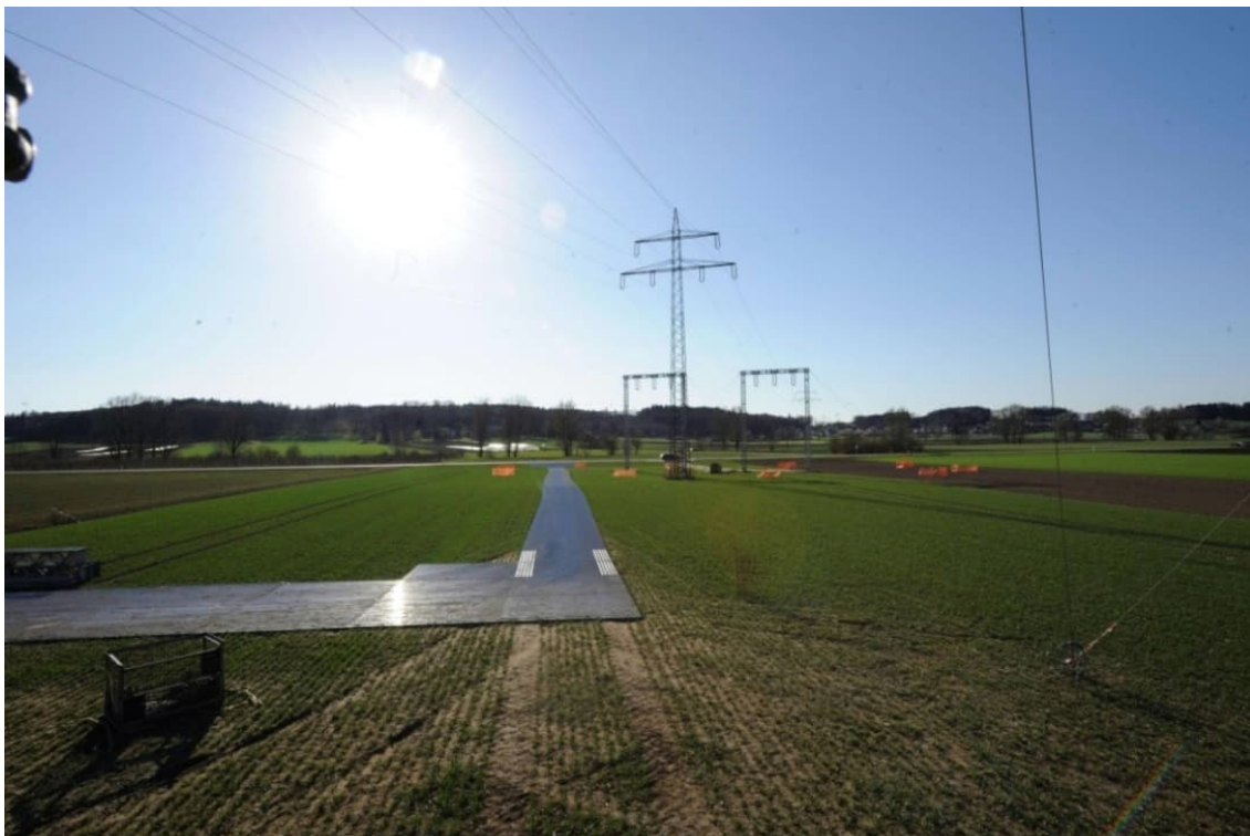
Abbildung 9: Baustraße als Plattenzufahrt bei einer Freileitungsbaustelle
