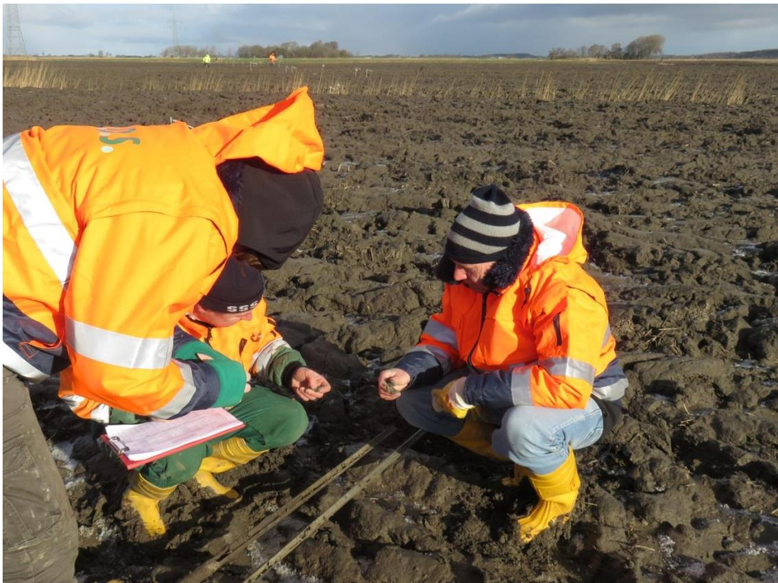
Abbildung 4: Durchführung von Bodensondierungen entlang der NordLink-Landtrasse
