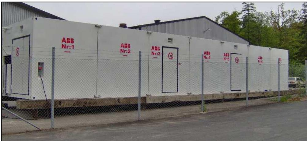
Abbildung 2: Muffencontainer zur Herstellung des Kabelverbindungssystems
