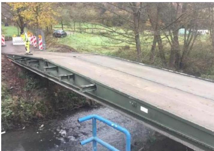
Abbildung 5: Beispiel für die Querung eines Vorfluters mittels mobiler Brückenkonstruktion
