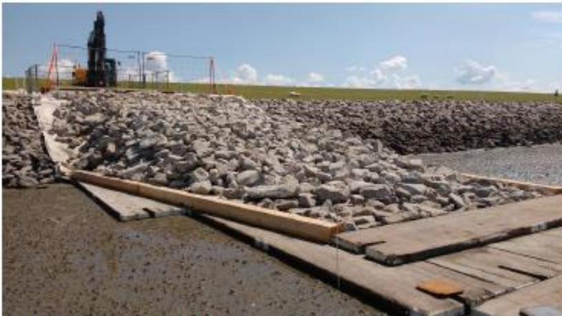
**Abbildung 11: Beispiel für Wattrampe ins Büsumer Watt (Foto Projekt NordLink, aus dem NFB-Bericht)**
