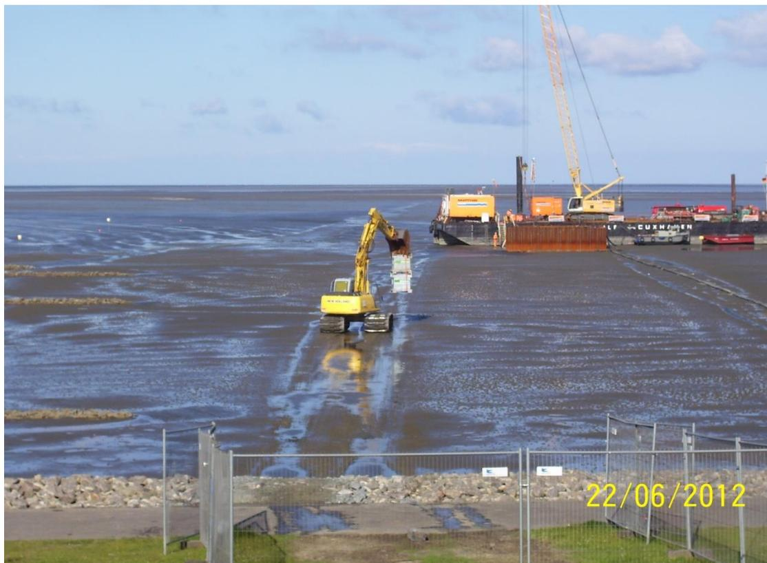
**Abbildung 9: Beispiel für einen Arbeitsponton mit Spundwandkasten und Wattbagger
