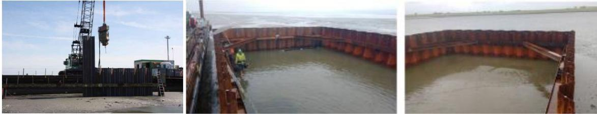
**Abbildung 12: Beispiel für Spundwandkasteneinbau im Büsumer Watt (Aufnahmen Projekt NordLink)**
