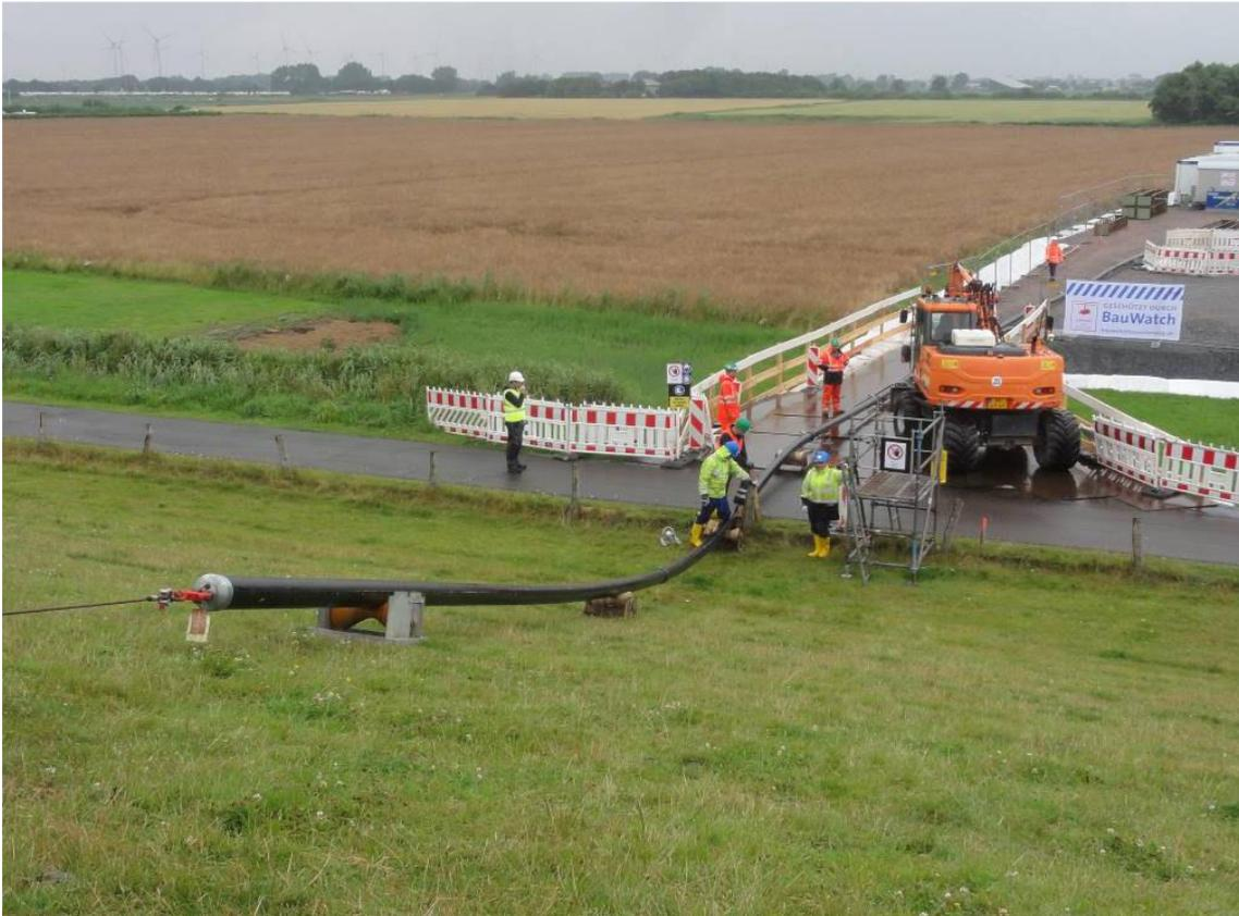
**Abbildung 14: Beispiel Ausbringen einer Rückspüleleitung über den Landesschutzdeich (Projekt Nord-Link)**
