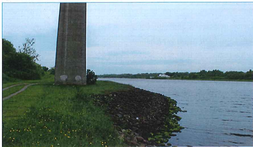
Bild 6a: Rader Hochbrücke, vorhandene Schutz-Böschung (Quelle: DEGES)
