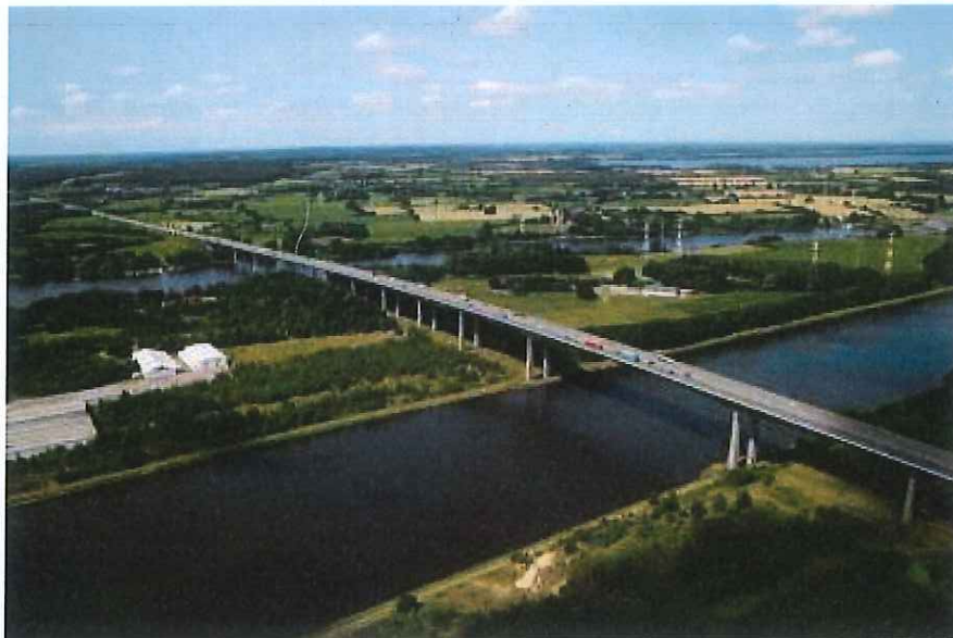
Bild 5: Rader Hochbrücke, NOK-km 68,1 (Quelle: DEGES)
