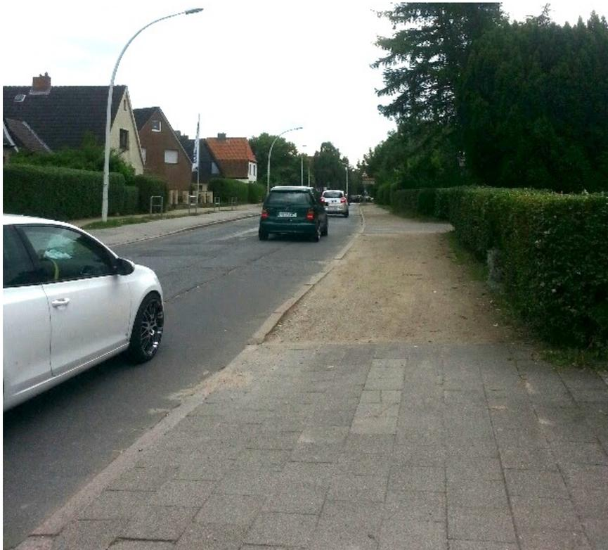
**Abbildung 8:** Beispiel für vollversiegelte Flächen (Fahrbahn, Radweg, Zufahrten) und teilversiegelte Flächen (Gehweg-Bereiche mit wassergebundenem Belag).
