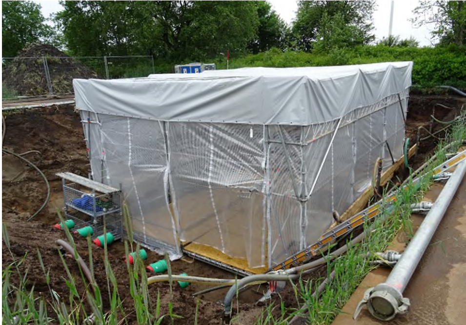
Abb. 14: Beispiel für einen Muffenverbau
