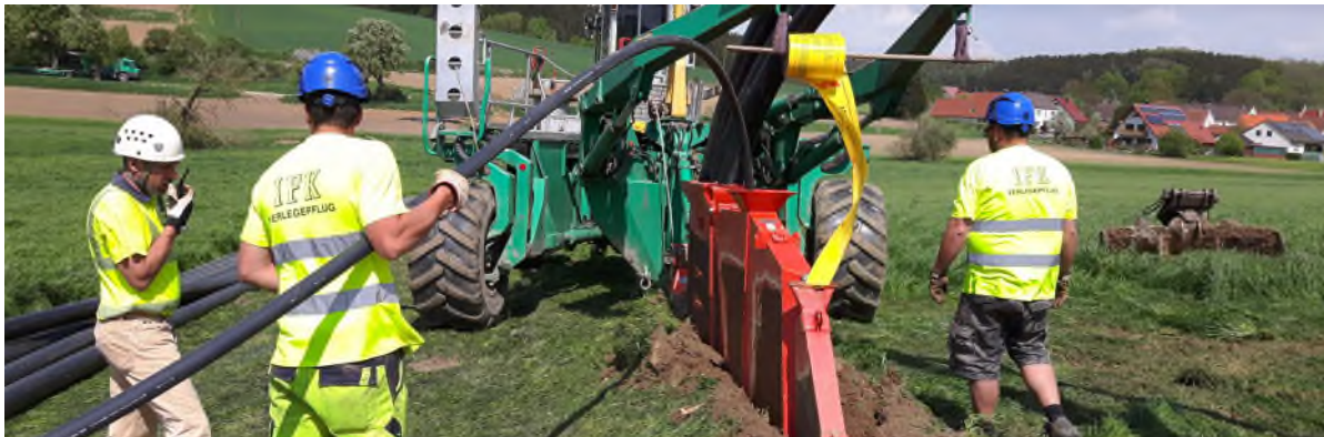
Abb. 12: Beispiel für das Einpflügen von Kabeln inkl. Trassenwarnband ( www.verlegepflug.at )
