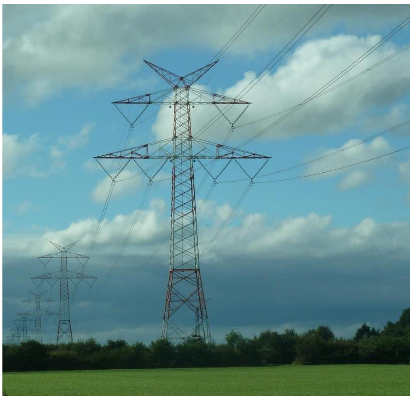
Abbildung 2: Tragmast einer 380-kV-Leitung
