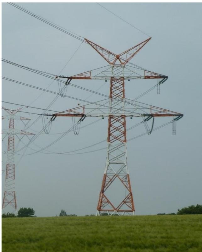
Abbildung 1: Abspann-/Winkelmast einer 380-kV-Leitung
