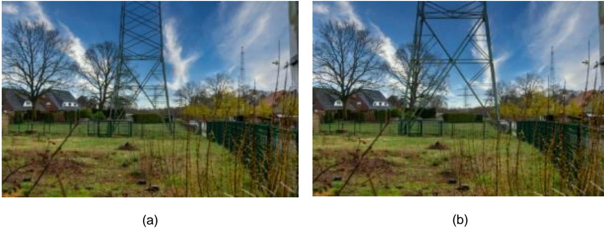
**Abbildung 25: Mast 2, Grafik a: bestehender Mast, Grafik b: geplanter Mast der 380-kV-Leitung (zur Veranschaulichung skaliert, nur annähernd maßstäblich)**
