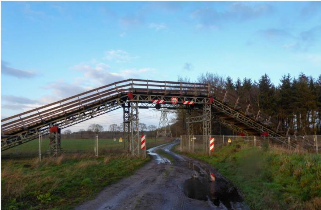
**Abbildung 15: Beispiel einer Kabelbrücke für ein Baueinsatzkabel**
