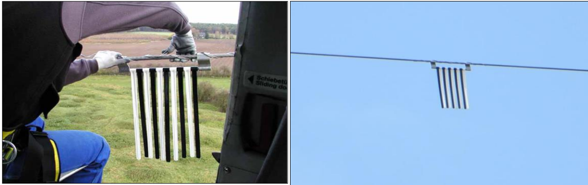
Abbildung 5: Vogelschutzmarker am Erdseil. Dem Stand der Technik entsprechen bewegliche, schwarz-weiße Lamellenmarker.
