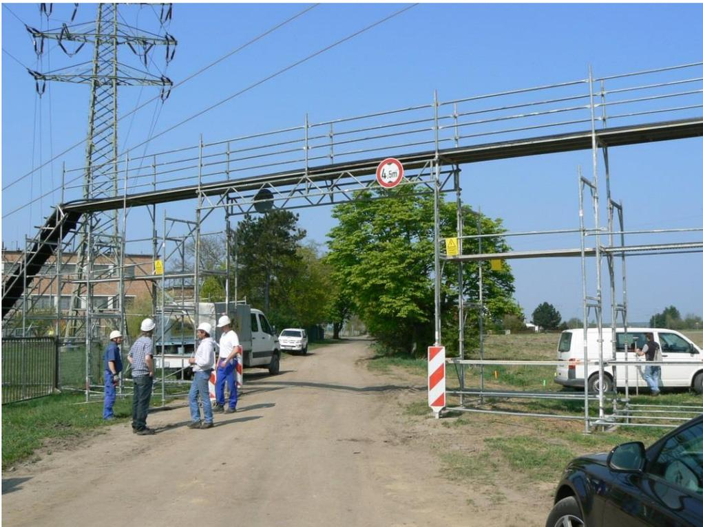
Abbildung 19: Beispiel einer Kabelbrücke über einen Weg
