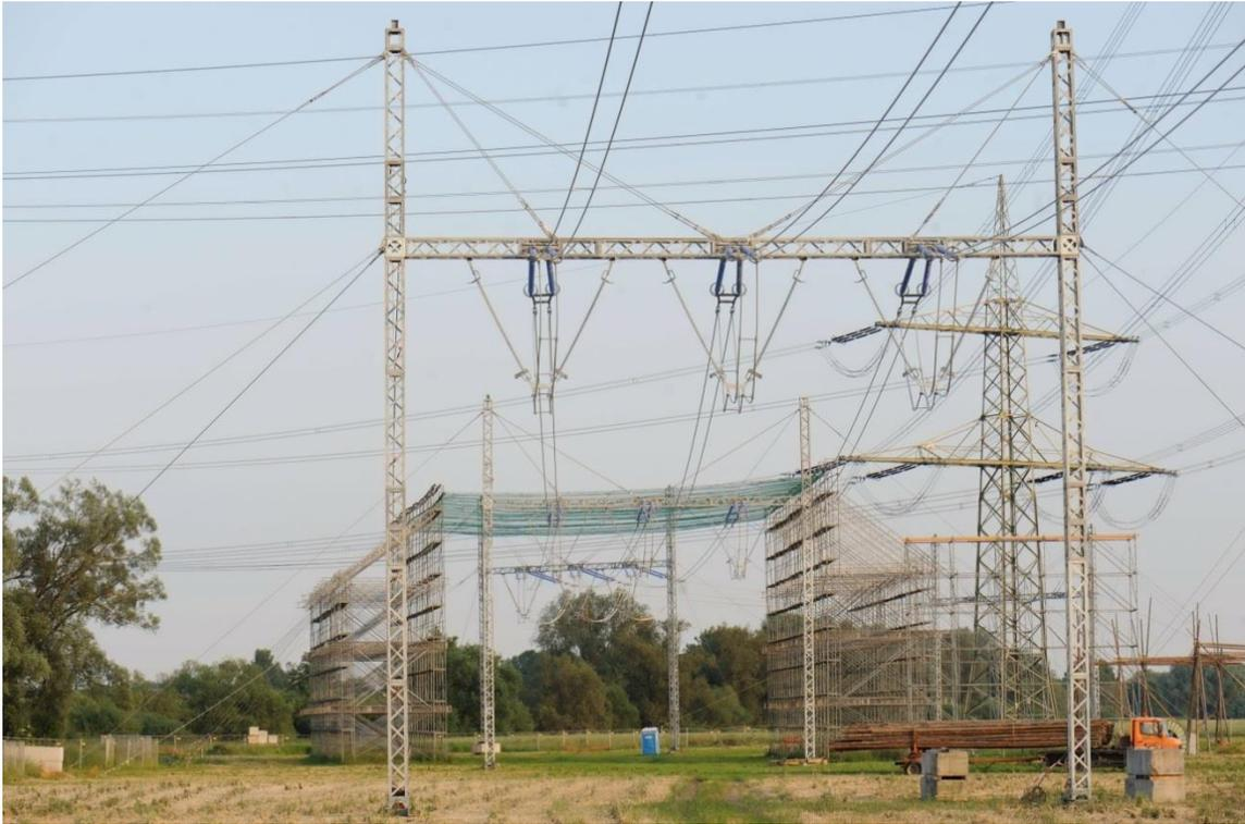
Abbildung 18: 380-kV-Freileitungsprovisorium für ein System, mit errichtetem Schutzgerüst
