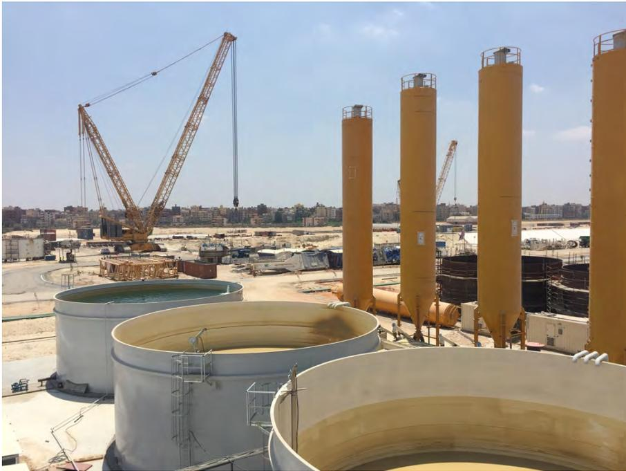
Bild 2: Becken mit Frischbetonit und Bentonitmischanlagen
