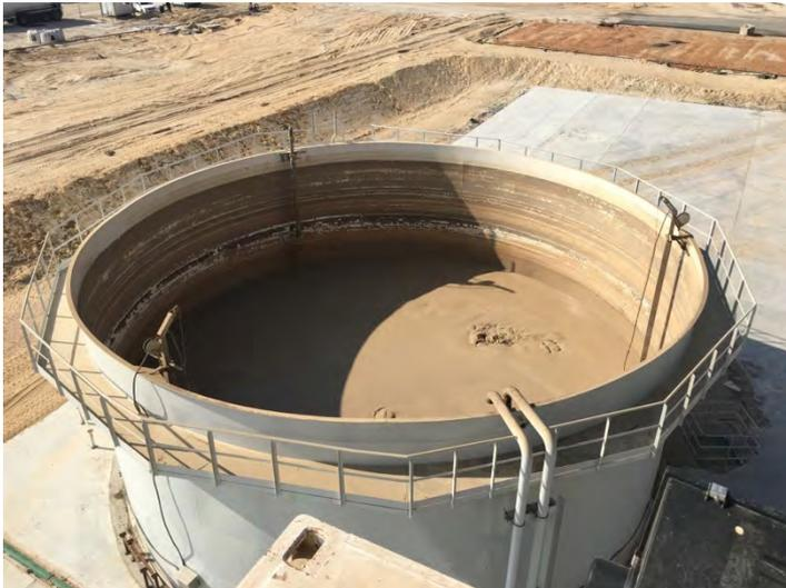
Bild 5: Altbentonit zur Aufbereitung gesammelt im Altbentonitbecken
