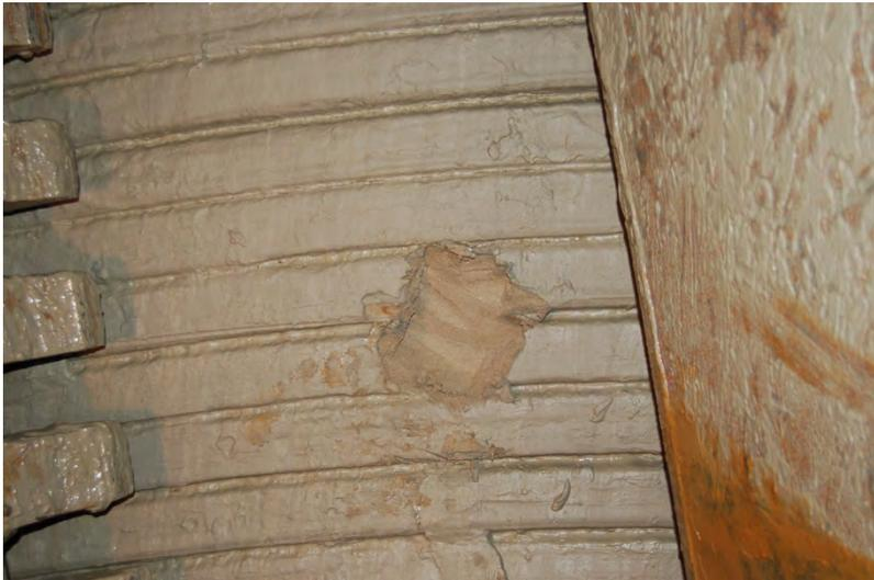
Bild 4: Ortsbrust durch das Schneidrad fotografiert. Bentonitfilterkuchen mit Werkzeugspuren und eine Fehlstelle zur Entnahme einer Bodenprobe
