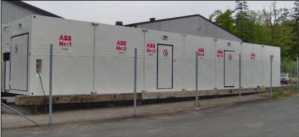
Abbildung 35: Beispielhafte Darstellung eines Muffencontainers zur Herstellung des Kabelverbindingssystems
