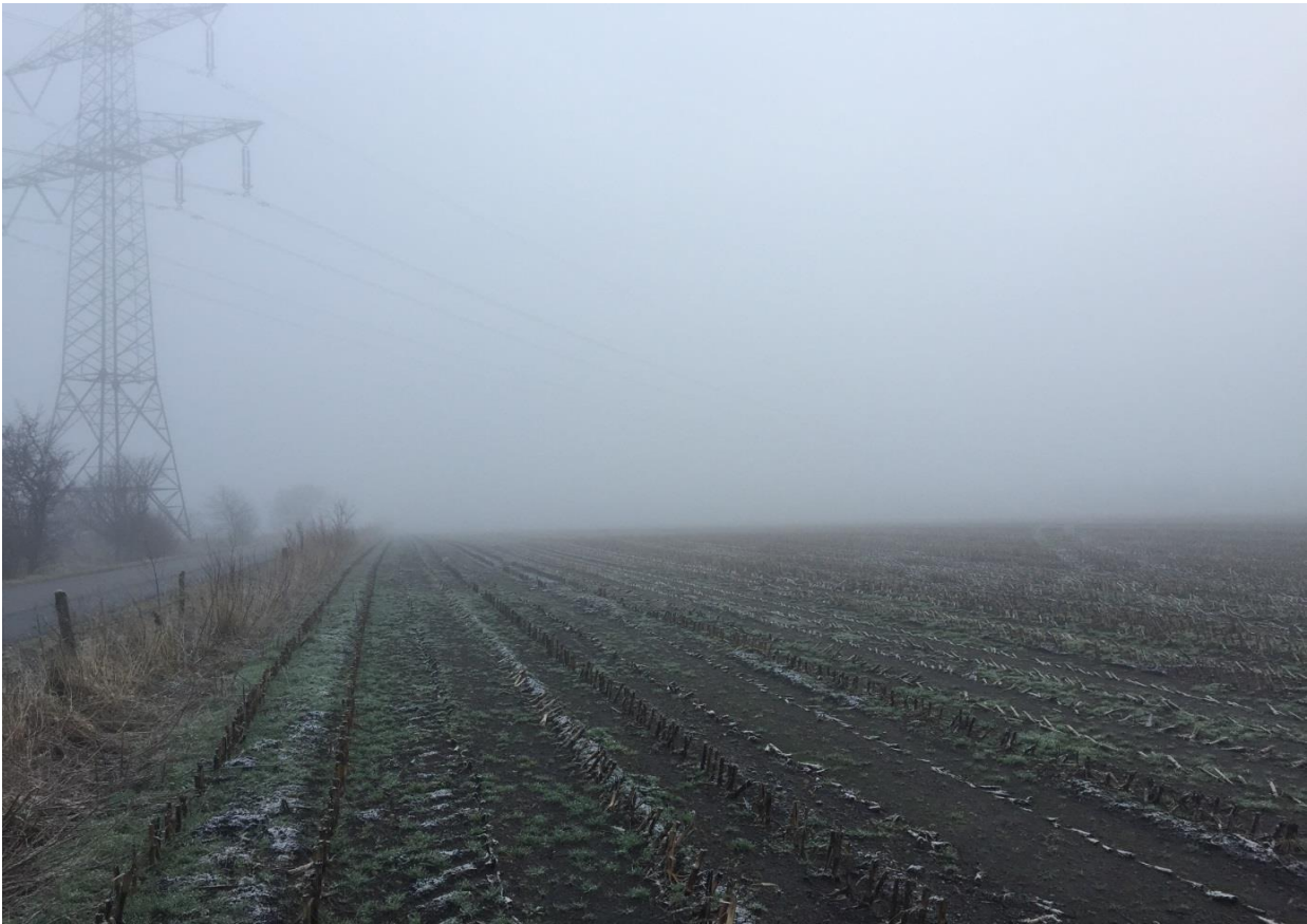
Bild 1: Maststandort; Blickrichtung: Süd
