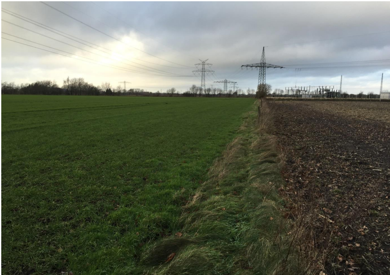
Bild 1: Maststandort; Blickrichtung: Nord
